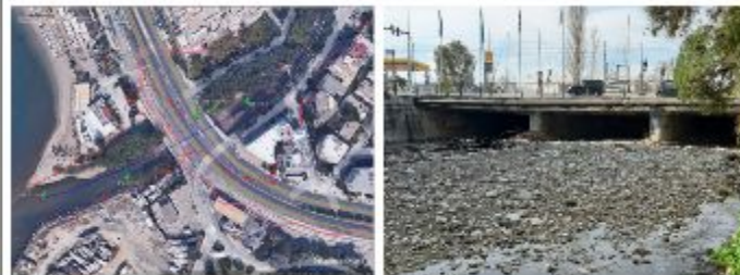
RI-P3-G: Γέφυρα Λεωφόρου Ποσειδώνος στο ρέμα Πικροδάφνης
